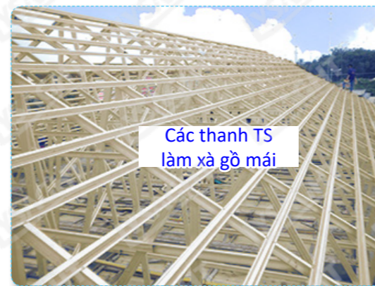
Hình 9.1.6.a Hệ xà gồ TS
