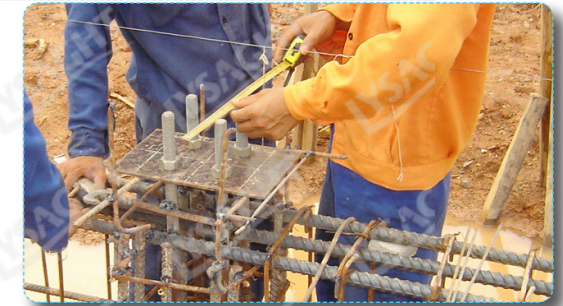
Hình 8.2.4.a Kiểm tra bu lông neo trước khi đổ bê tông
