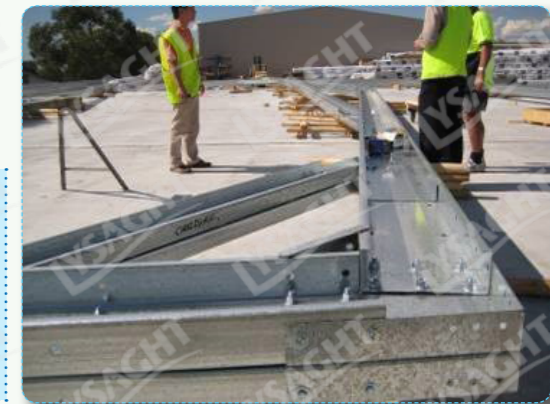
Hình 8.3.1.b Tổ hợp khung: chi tiết nối cột-kèo (knee)
