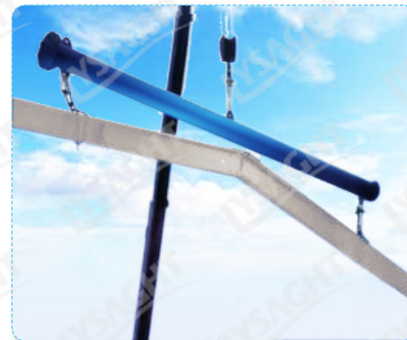
Hình 8.4.2.3 Cầu dầm dài với đòn gánh
