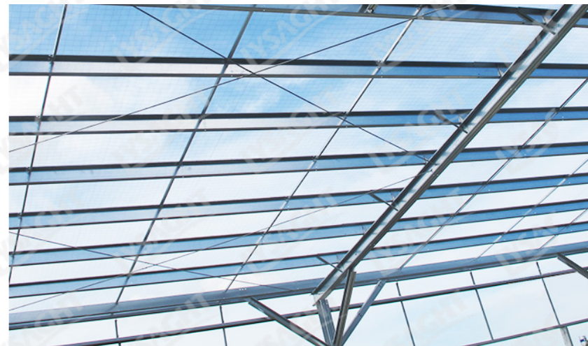
Hình 8.1.5.b Thanh tiết diện Z làm xà gồ
