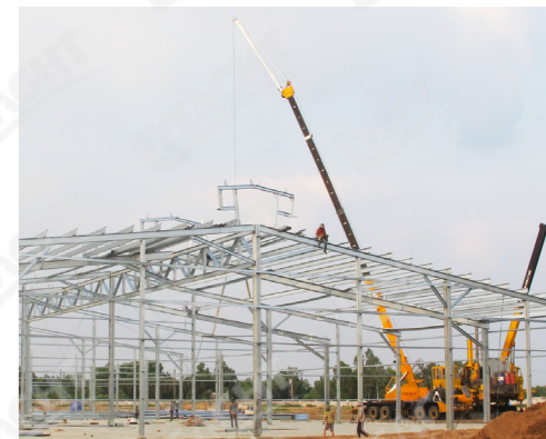
Hình 8.2.2.b Lắp khung bằng cầu
