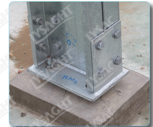
Hình 8.2.4.b Chỉnh cao độ và chờ đổ vữa chèn
