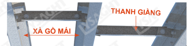
Hình 7.4.2.b Lắp mỗi thanh giằng C51 vào 2 pat giằng
