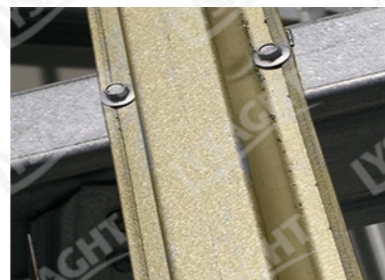
Hình 7.5.2.b Bắn vít ở phần cánh dưới thanh TS
