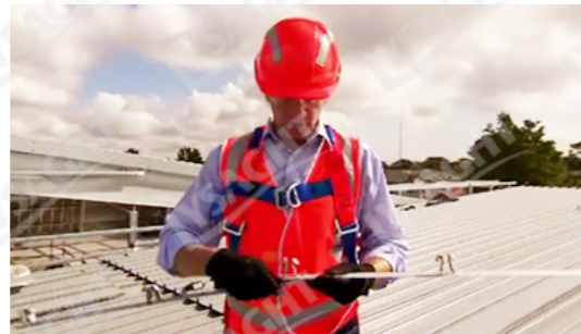
Hình 5.3.3.1.a Chiều lắp đai KL98
