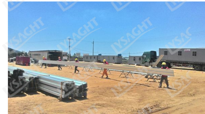
Hình 3.1.1.3 Tôn dài được cán tại công trường
