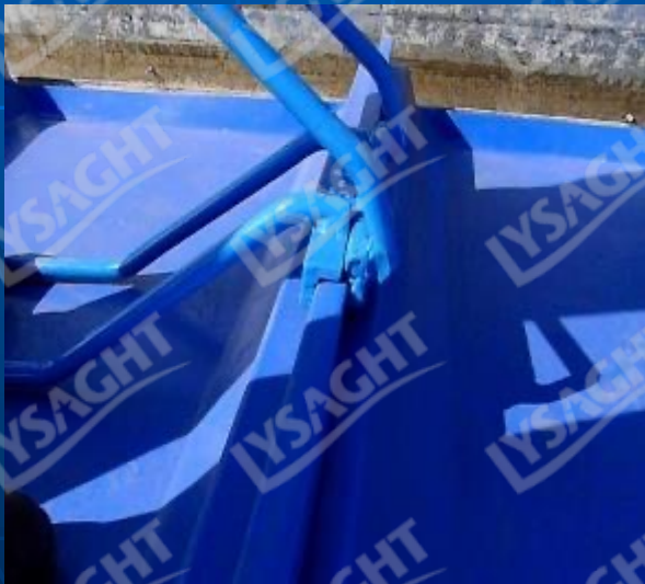
Dụng cụ seam bước 1
