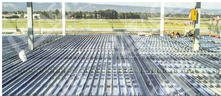
Hình 7.1.3.b Một sàn Bondek® II với các đĩnh (chốt) chống cắt
