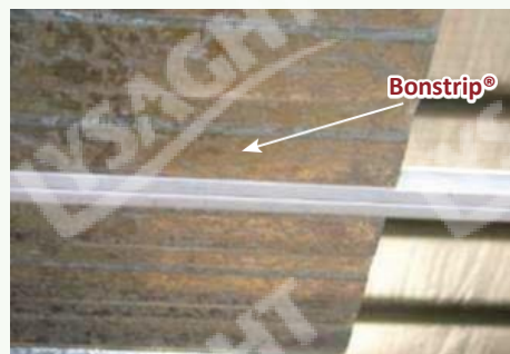
Hình 7.3.11.b Cách 2: Cài Bonstrip® và bắn tấm trần thạch cao vào Bonstrip®
