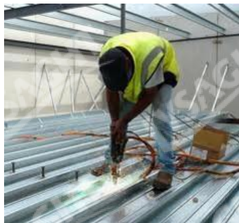
Hình 7.1.3.c Hàn đĩnh chống cắt (shear stud)
